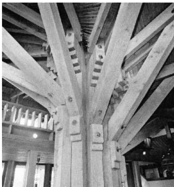
2. ábra – Tölgyből készült tetőszerkezet tartó oszlopa
