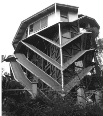
8. ábra – Az alsó három szint külső falaira kitülő, hullámlemez borítású negyedik szint
